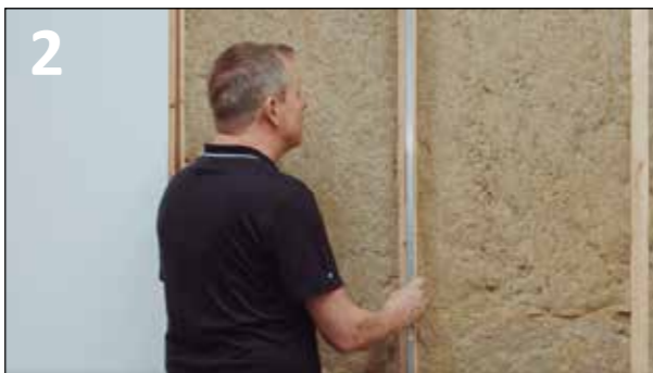
2 KONTROLLER AT VÆGGEN ER I LOD FØR MONTERING
