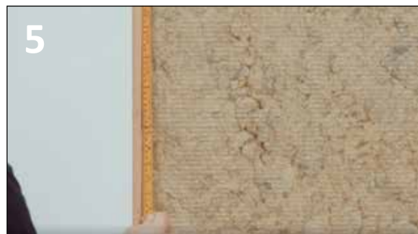
5 SKRUES PR. 20CM. BENYT HUNTONIT SKRUE 4,2X35MM. DESUDEN SKRUES OGSÅ I TOP OG BUND. DISSE SKRUER DÆKKES AF FODLISTE/SKYGGELISTE.
